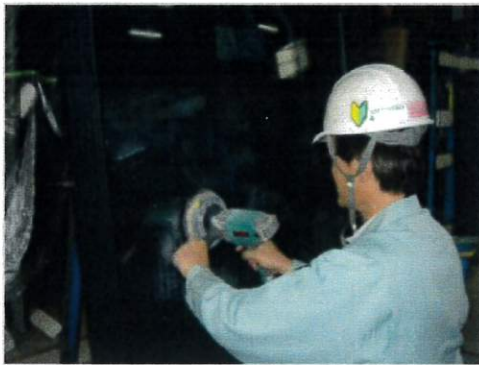
〔下地調整作業①ーポリッシャー処理〕
