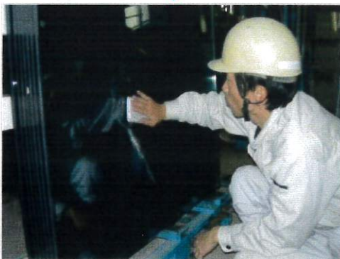
〔下地調整作業②ー洗浄剤除去〕
