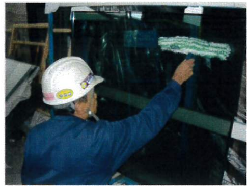
〔下地調整作業④ーリント処理〕
