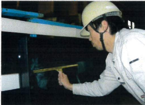
〔下地調整作業③ークスイージー処理〕
