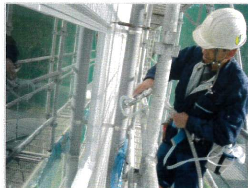
〔光触媒コーティング②ー縦方向塗布〕
