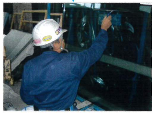
〔下地調整作業⑤ークスイージー処理〕
