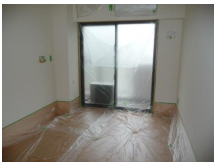
【 Masking of un-coating part 】
